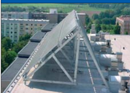
Abb 4: Stahlprofil-Aufständerung der Solarkollektoren
