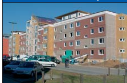
Abb 2b: während der Sanierung
