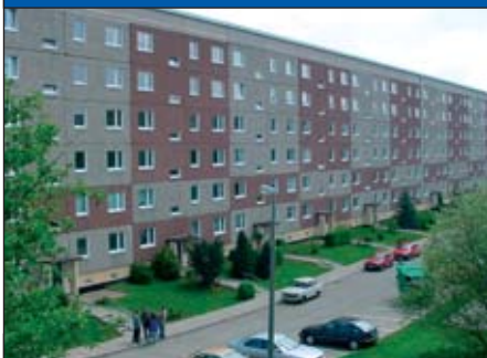
Abb 2a: Plattenbau (WBS 70) vor der Sanierung
